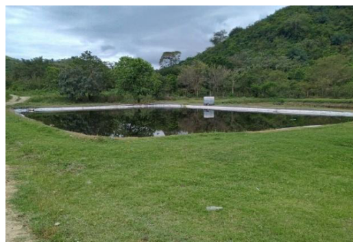
Laguna de evaporación de lixiviados
