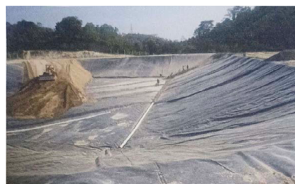
Instalación de rampa para el depósito de los residuos sólidos en la Celda 1 y la laguna de lixiviados.
