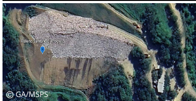
Relleno Sanitario (cierre técnico con operación mejorada)
