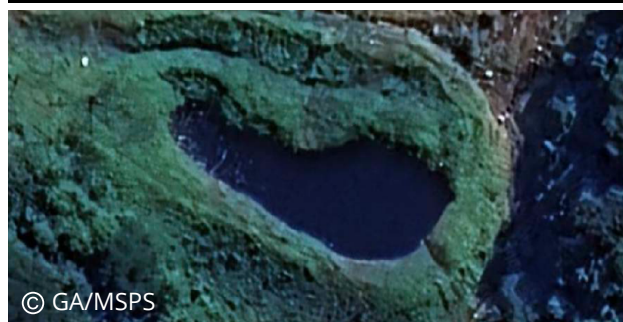
Laguna de lixiviados
