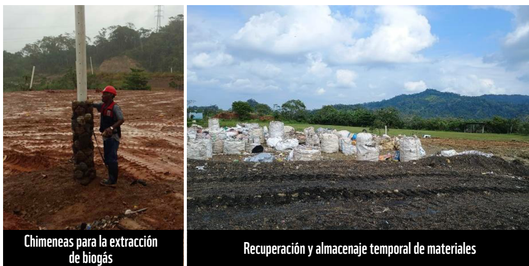
Imagen 19. Chimeneas para el biogás y almacenamiento de residuos valorizables.
