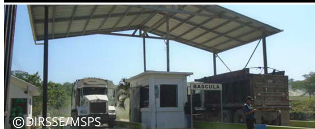
Básculas para el pesaje de camiones recolectores
